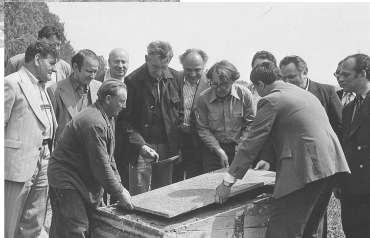
Закладка капсулы в фундамент первой колонны СМК с посланием комсомольцам через 50 лет в фундамент сборочно-монтажного корпуса опытного производства Института Космических Исследований Академии Наук СССР
